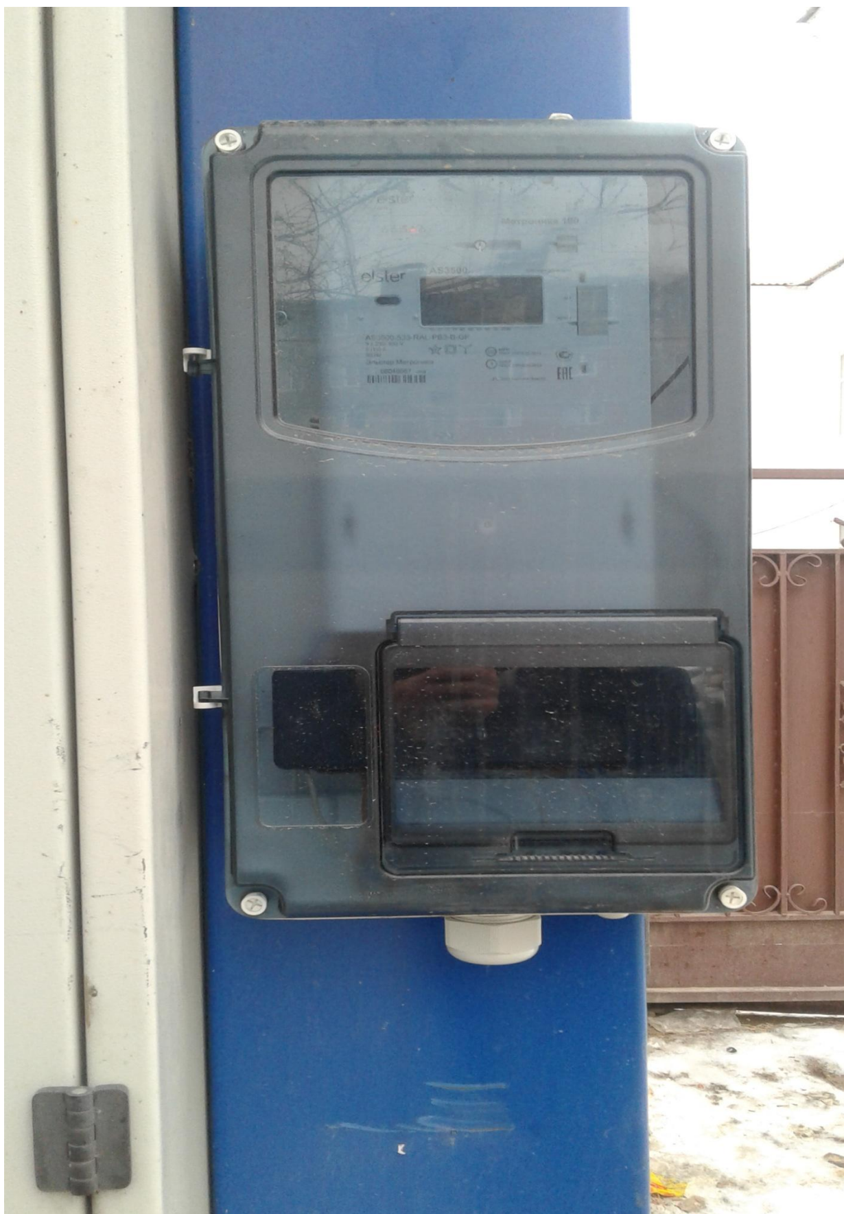
Шкаф учета ЭЭ трехфазный в г. Кызылорда
