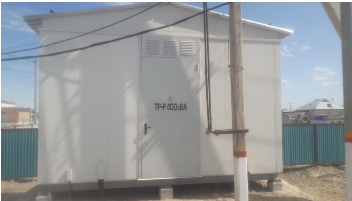
КТПБ-10/0,4 кВ 400 кВА в сельском округе Кызылжарма г. Кызылорда
